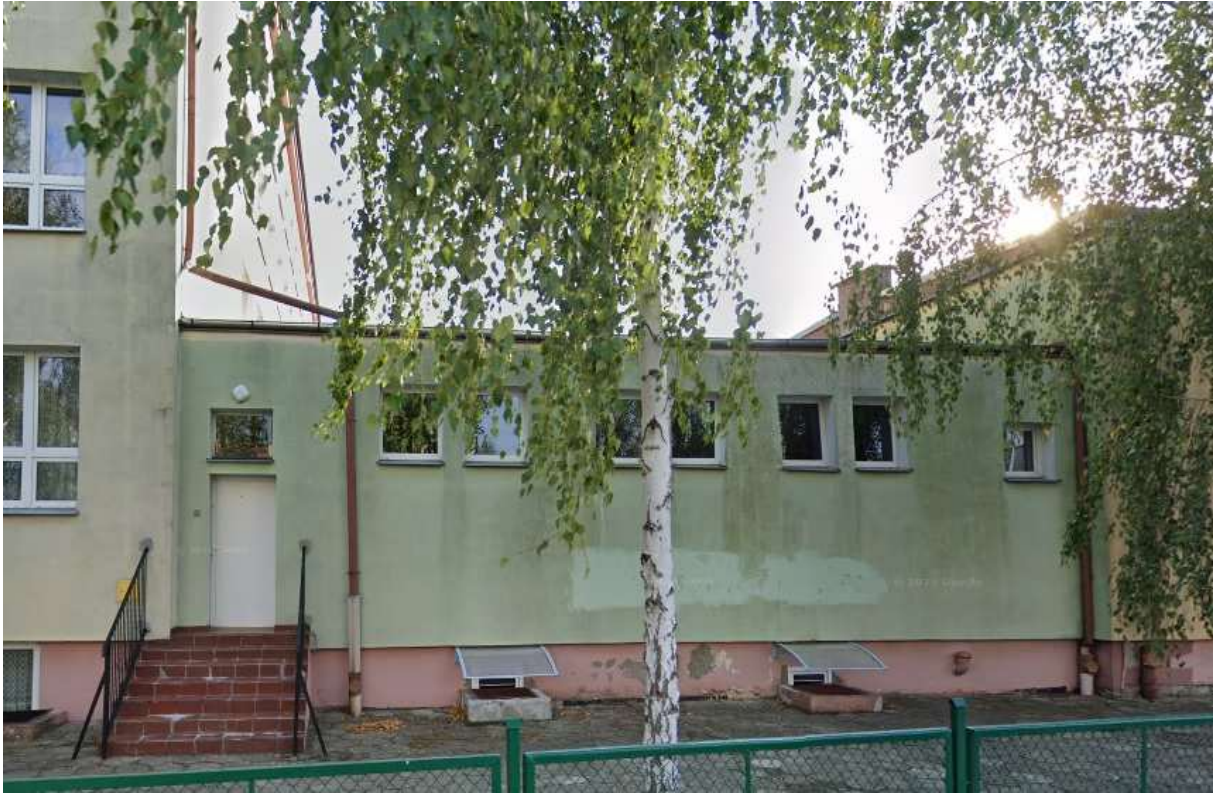
Widok elewacji tylnej (zachodniej)
