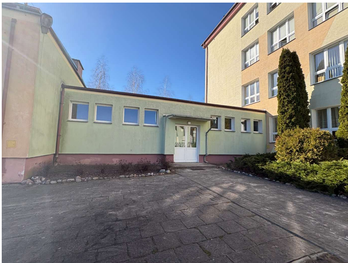
Widok elewacji frontowej (wschodniej)
