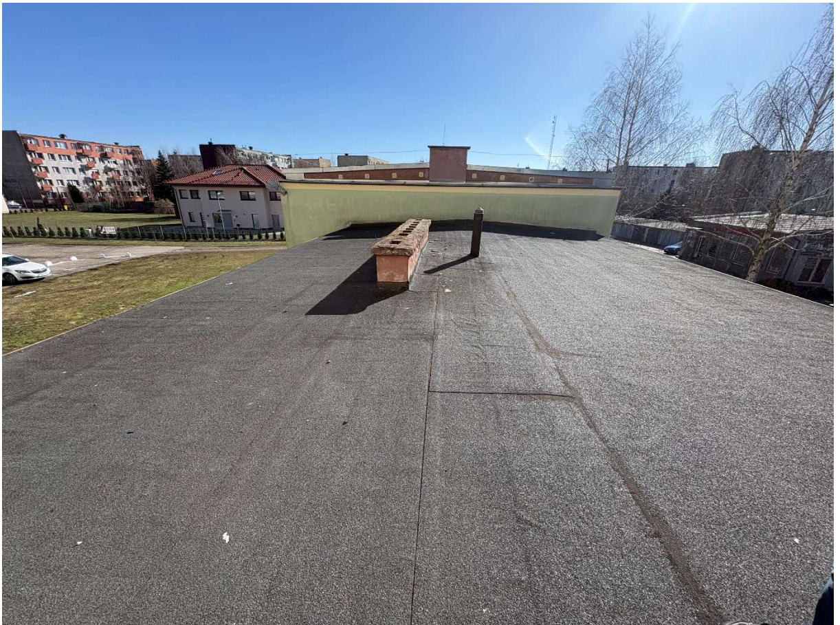
Widok dachu budynku
