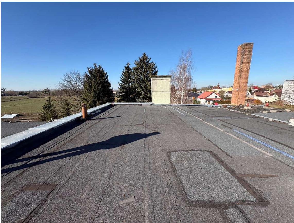
Widok dachu budynku
